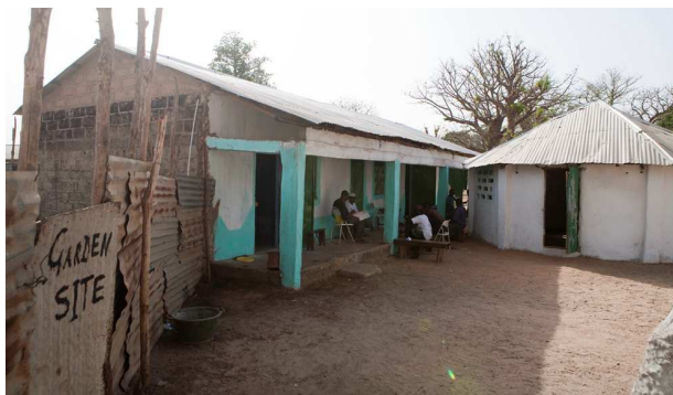
Neues Gebäude mit Administration und Gästeräumen (links), Klassenzimmer mit neuem Dach (rechts)
